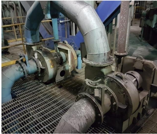
Ilustración 17: Ventilador cámara de TV y fotocelda
