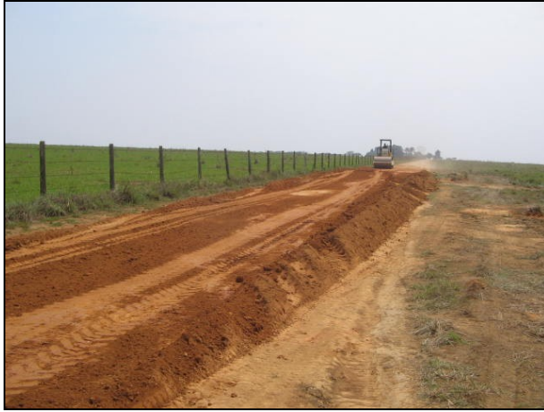
FOTOGRAFÍA 3: CONSTRUCCIÓN DE UNA VÍA DE ACCESO.
