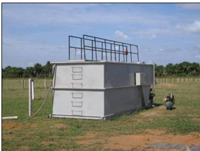
FOTOGRAFÍA 19: PLANTA DE TRATAMIENTO DE AGUAS RESIDUALES DOMÉSTICAS
