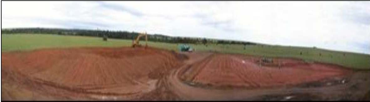
FOTOGRAFÍA 1: PANORÁMICA DE LA CONSTRUCCIÓN DE UNA LOCACIÓN Fuente: Autores
