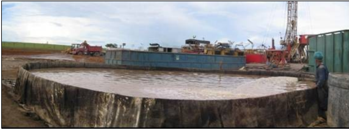
3.3.3 Producción FOTOGRAFÍA 20: TRATAMIENTO DE AGUAS RESIDUALES INDUSTRIALES Fuente: Autores
