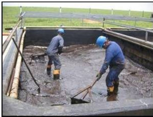
FOTOGRAFÍA 17: MANEJO DE FLOCS ACEITOSOS EN LOS LECHOS DE SECADO
