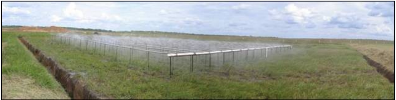
FOTOGRAFÍA 22: DISPOSICIÓN DE AGUA TRATADA MEDIANTE MICROASPERSIÓN Fuente: Autores
