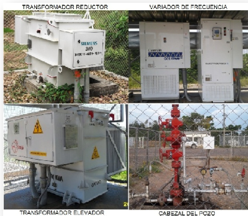
Figura 6 Componentes del Bombeo Electro Sumergible
