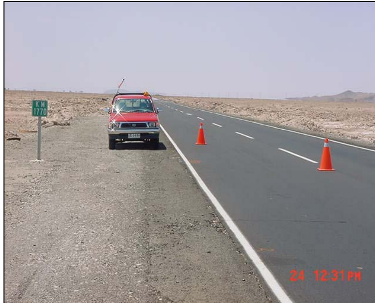
Figura 1. Estado de la vía antes y después del deterioro.
