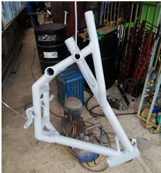
Figura 74. Aplicación de base anticorrosiva a la estructura.
