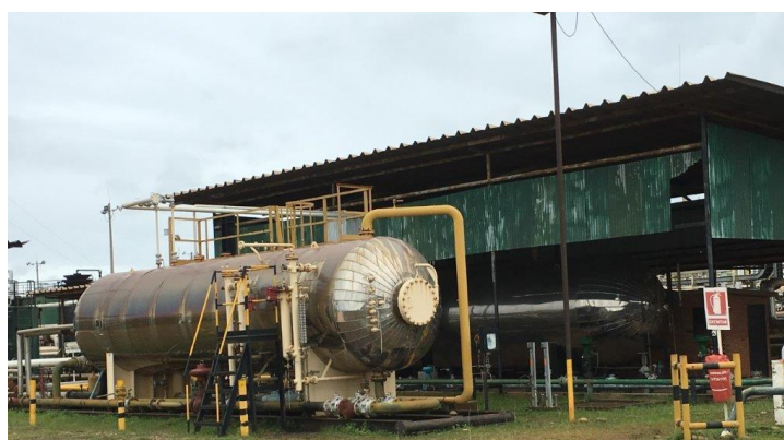
Figura 5. Tratador Térmico horizontal.
