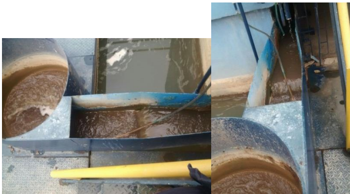
Figura 6. Canaleta Parshall y mezcla rápida.
