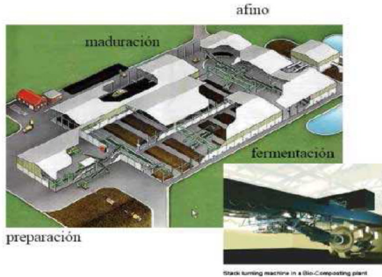
Fotografía 40. Estructura física de una planta de compostaje
