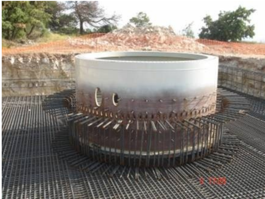
Figura 14. Colocación de la parrilla inferior y de la virola
