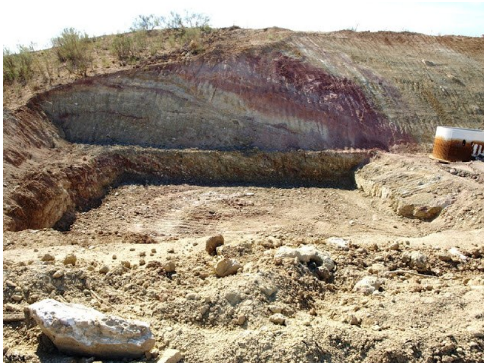
Figura 12. Excavación para la cimentación
