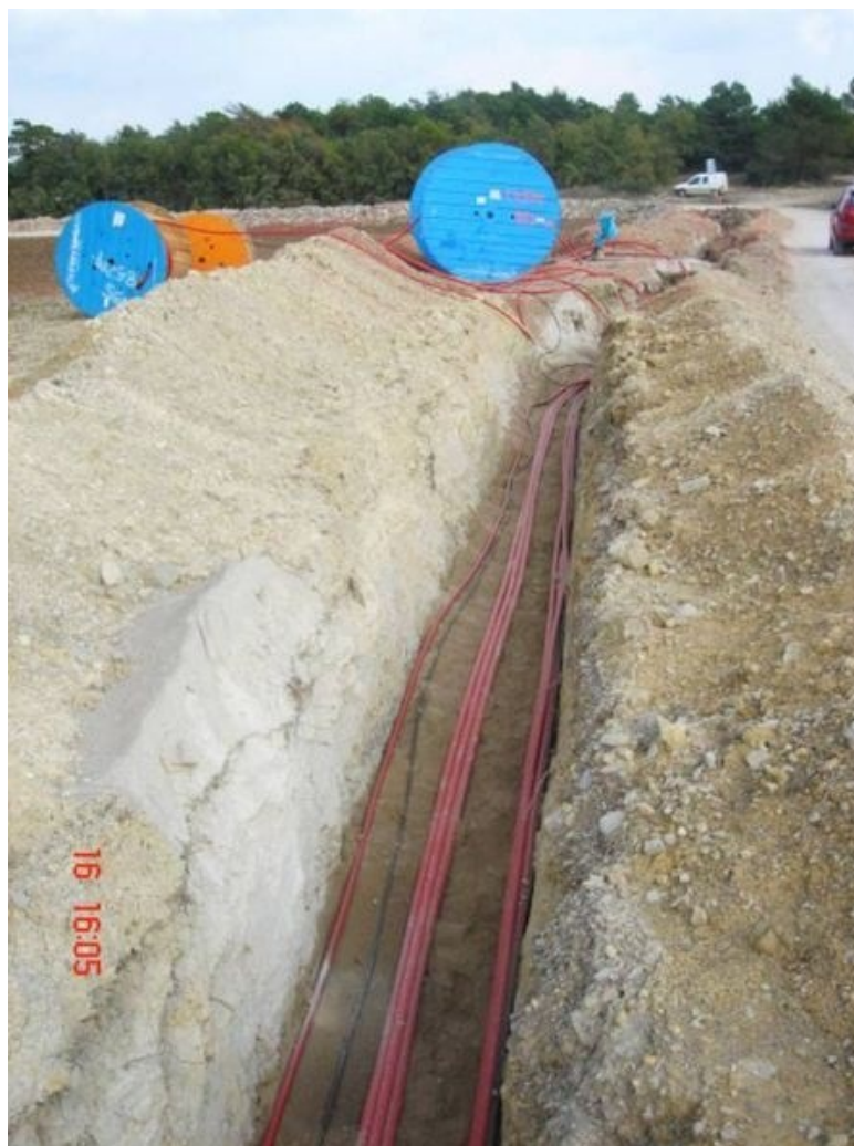
Figura 20. Excavación para proteger los cables que conducirán la energía eléctrica al transformador
