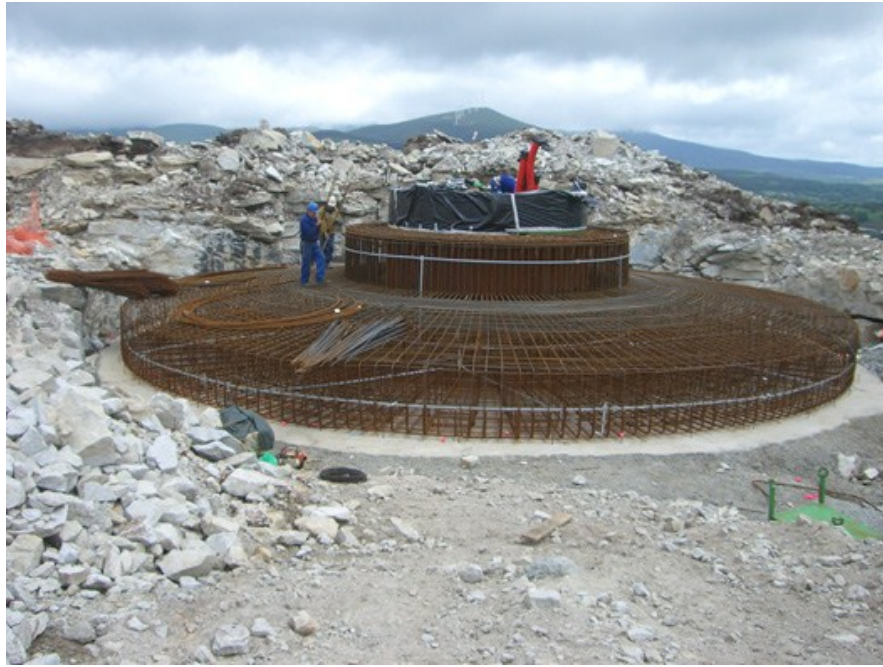
Figura 16. Colocación de la parrilla superior
