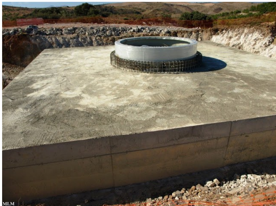
Figura 19. Cimentación terminada
