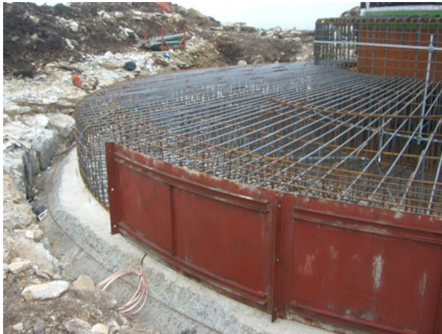
Figura 17. Encofrado de la cimentación
