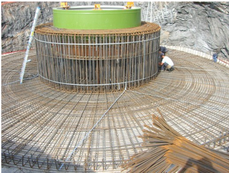
Figura 15. Colocación de acero de refuerzo entre la cimentación y la virola
