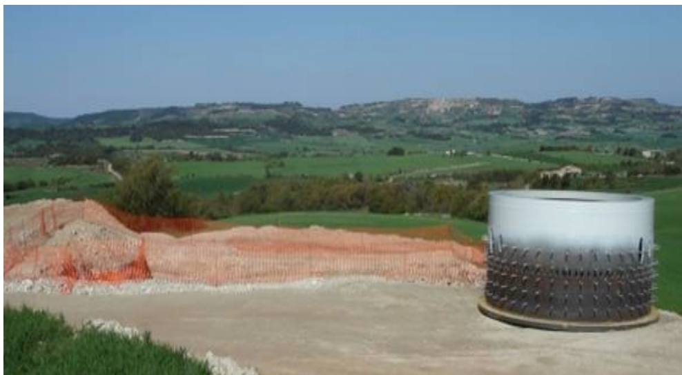
Figura 13. Nivelación de la cimentación para emplazamiento de la torre
