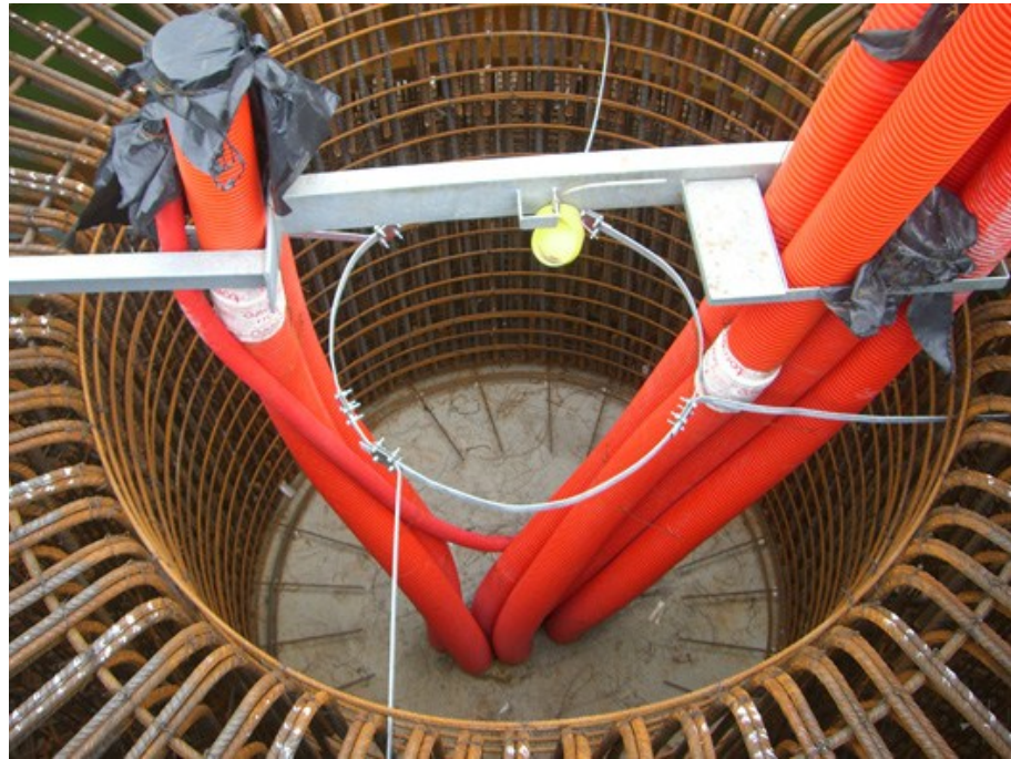
Figura 18. Virola con la instalación de tubo corrugado por donde pasaran los cables.
