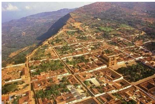
Figura 1. Panorámica del Municipio de Barichara
