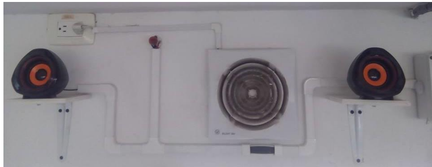
Figura 51. Parlantes y lámparas ubicados cerca al controlador
