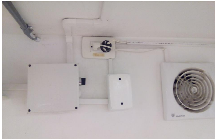
Figura 47. Instalación de la caja del controlador del sistema, selector y fuentes de alimentación
