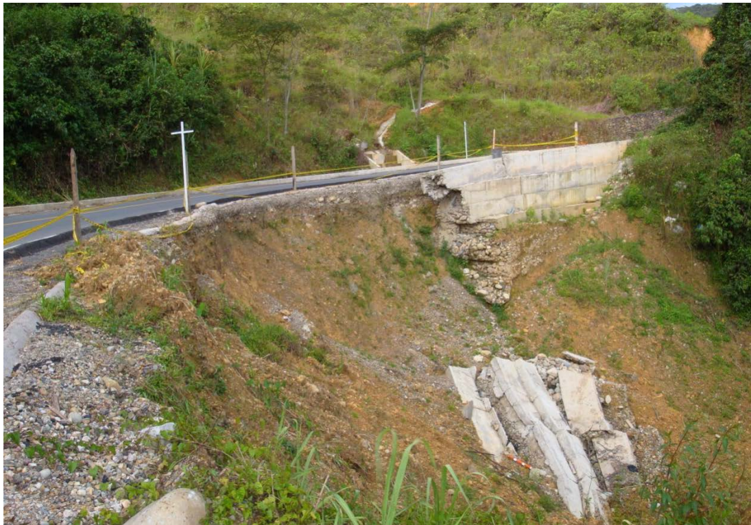
Ilustración 1: Estado actual del talud
