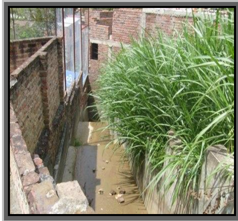
Canalización del afluente de la Quebrada la Magnolia en el Barrio Santa María, el cual continúa su paso por el Barrio el Cedral pasando por debajo de las edificaciones.
