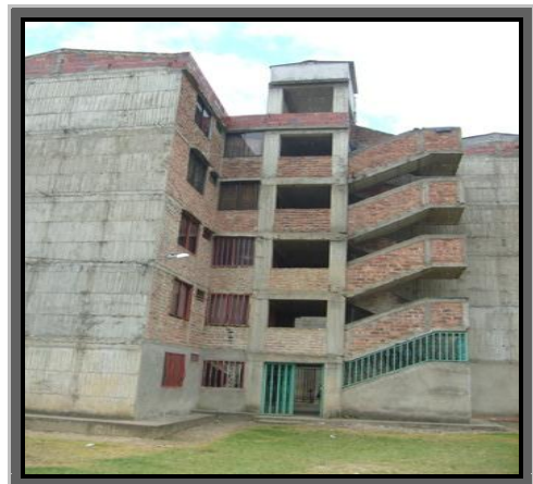
Edificaciones localizadas a pocos metros de la Quebrada la Magnolia
