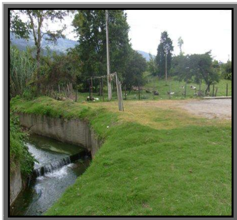
Paso de la Quebrada la Magnolia (Canalizada) por el Barrio ASOVIPAR.
