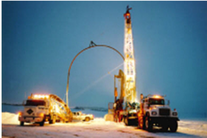
Figura 15. Fotografía de instalación de un sistema de varilla continúa.
