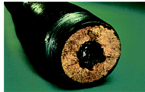
Control de los Depósitos
