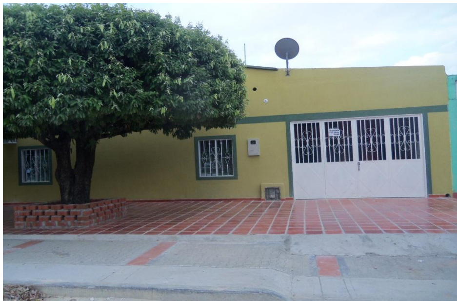
Casa seleccionada para las instalaciones de TRANSAL LTDA, ubicada sobre la via del malecon
