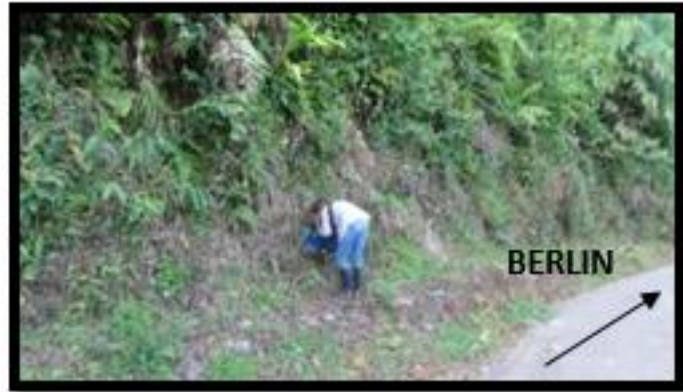
Foto 76. Zona cubierta por vegetación.
