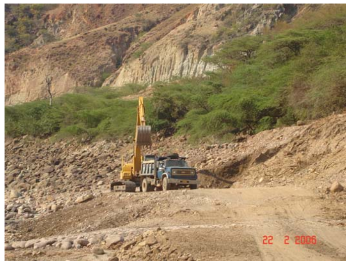
Foto No 16. Cargue del material de río para ser llevado a los stoks.
