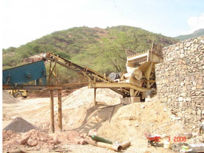
Foto No 21. Sub-base para pavimentación de vías.
