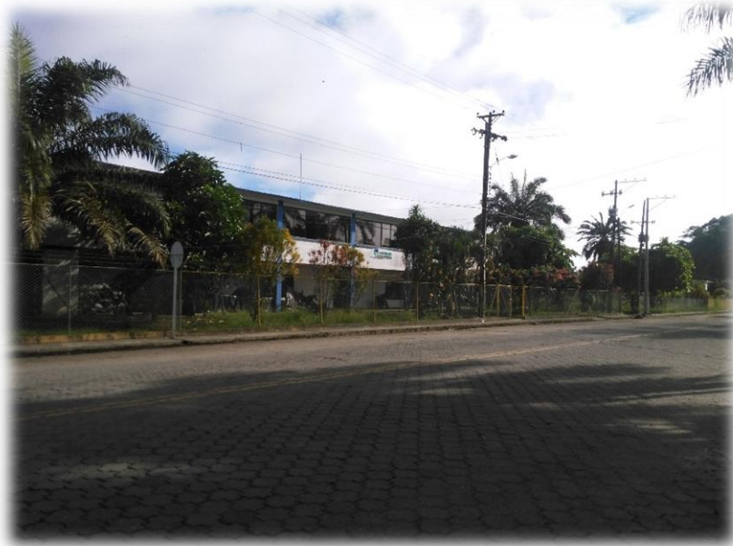
Fotografía 1. Vista Exterior CORPONARIÑO sede TUMACO.
