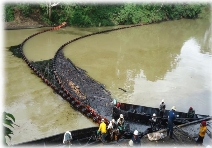
Fotografía 9. Barrera de contención, Río Caunapí, Comunidad “Pueblo Nuevo”, Tumaco – Nariño.
