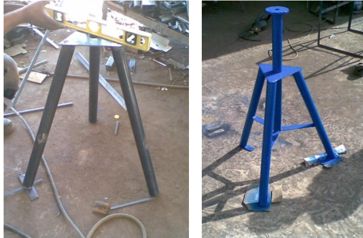
Figura 70. Construcción Estructura Soporte
