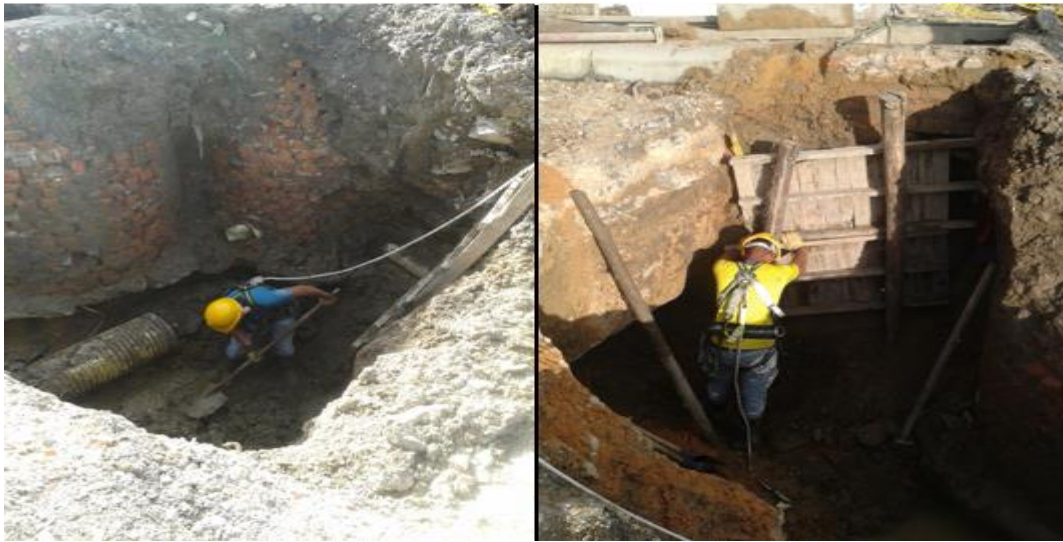
Figura 24. Trabajo en espacios confinados, adecuación de alcantarillado.
