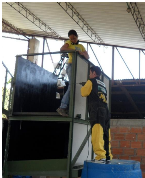
Foto 19. Instalación de paredes
