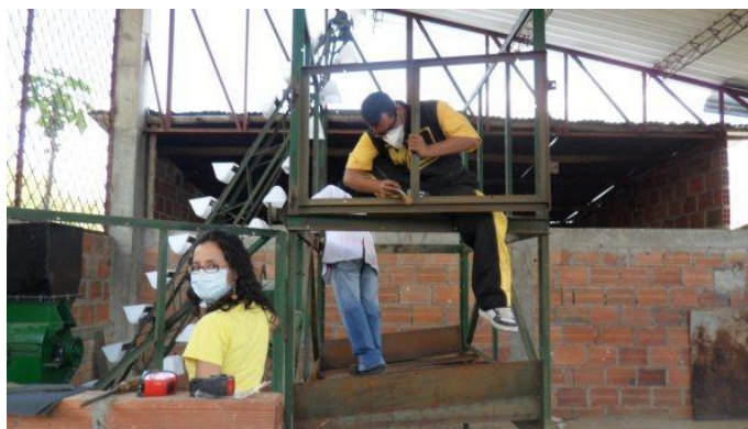
Foto 17. Proceso de remoción de óxido y desechos en el bio-reactor.
