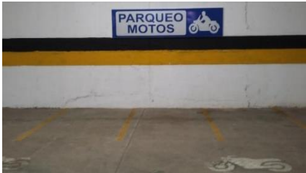
Figura 22. Parqueadero con pavimento en buen estado, P5- ubicado en la zona 5.
