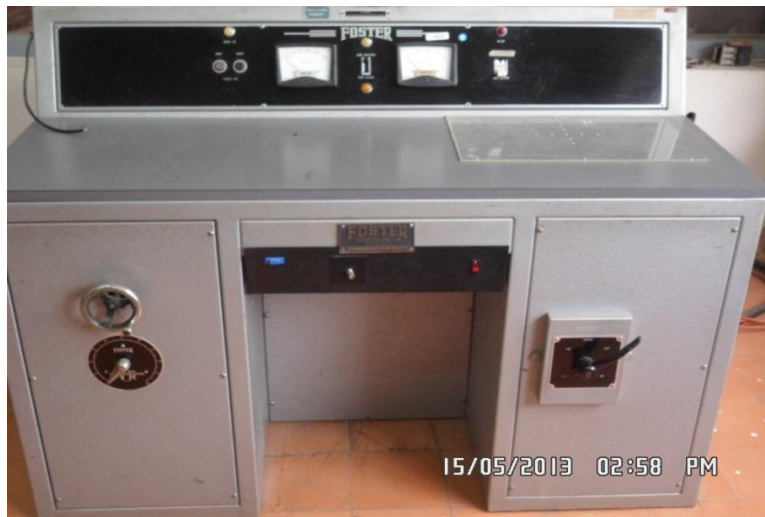
Figura 38. Consola de mando tensión alterna
