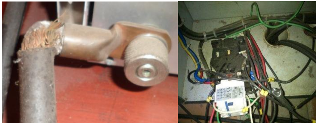
Figura 31. Punto de conexión del equipo de medición.
