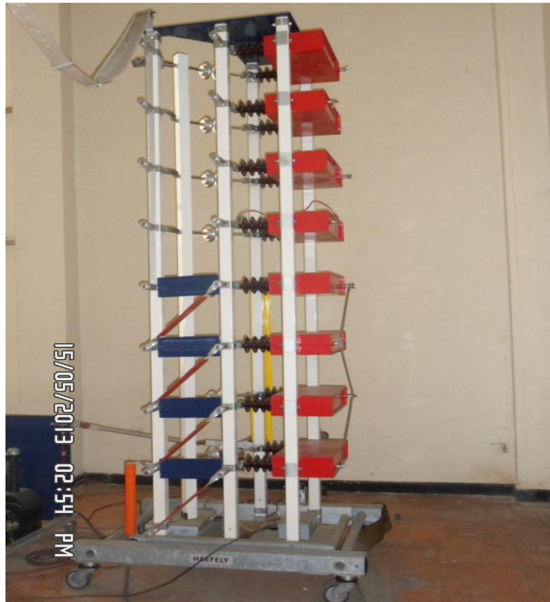
Figura 16. Generador de impulso de tensión.
