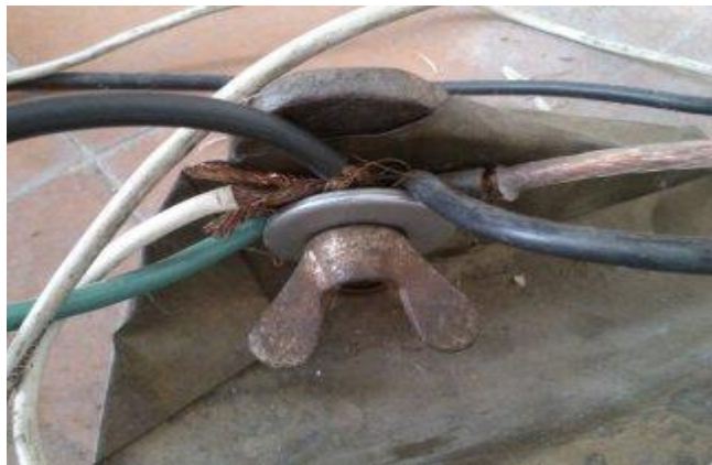
Figura 27. Punto de anclaje del SPT.
