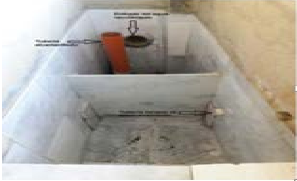
Figura 9. Estructura de remoción de materiales gruesos
