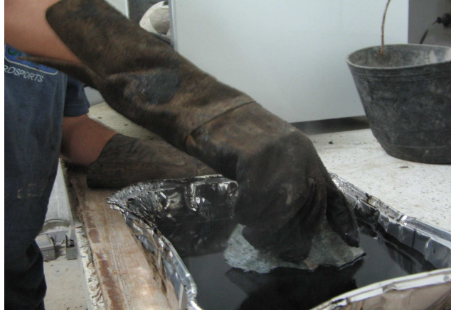
Figura 14. Capa de 1mm de espesor de asfalto.
