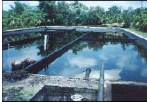
Figura 17. Piscinas de Almacenamiento de Agua Industrial
