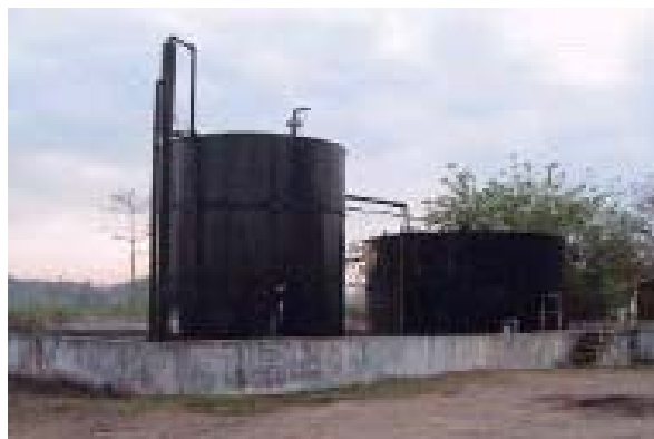
Figura 12. Tanques de la Estación 3
