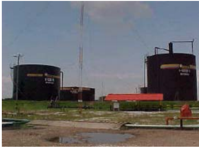
Figura 7. Área de Tanques
