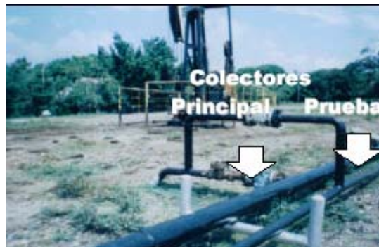
Figura 4. Sistema de Colectores Para Pozos
