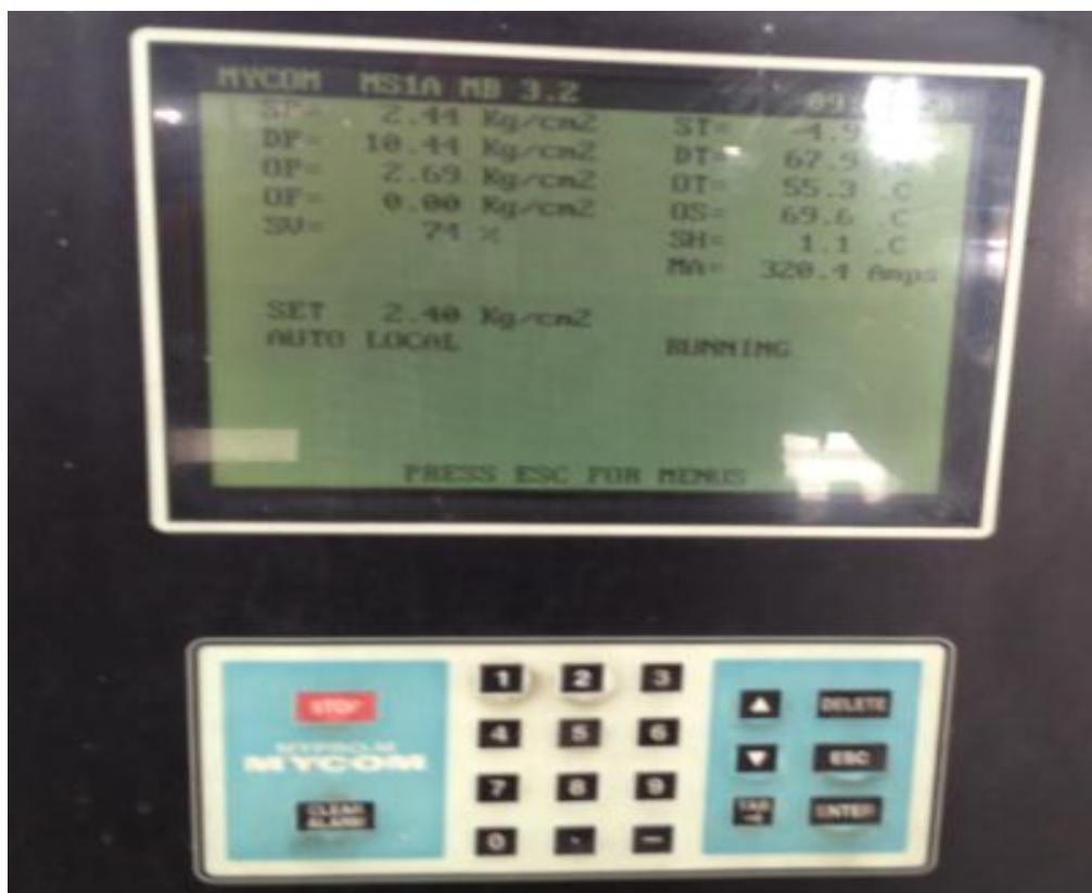
Figura 8. Pantalla donde se pueden modificar los parámetros de control del modo AUTO LOCAL.
