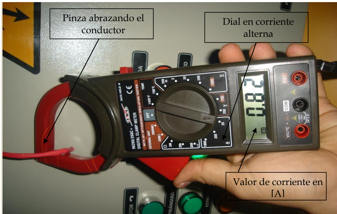
Figura 121. Medición de corriente con pinza voltiamperimétrica
