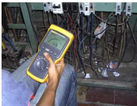
Figura 30. Medida de resistencia de aislamiento Fuente: Autores
