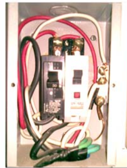
Figura 27. Tablero red diferencial - TUE. Fuente: Autores
