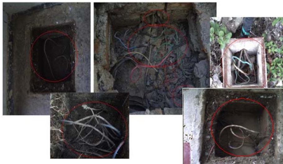
Figura Revisión 6: Acometidas Subterráneas Fuente: Autores
