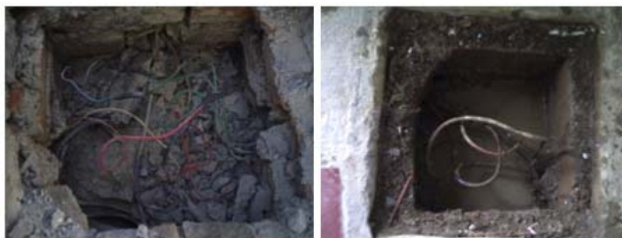
Figura 35. Cajas de paso Fuente: Autores
