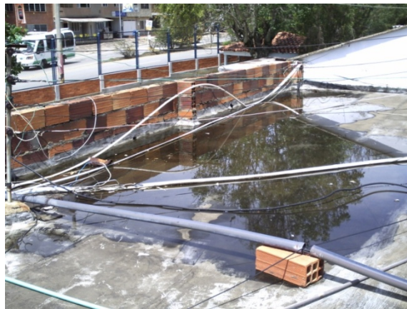
Figura 34. Salida de acometidas del tablero general TG en riesgo de falla Fuente: Autores
