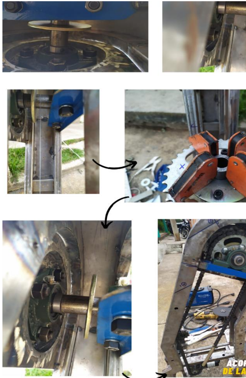
Figura 62. Proceso de construcción del adaptador de la catarina.
