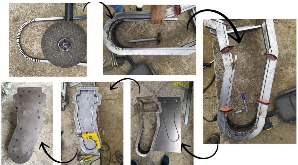
Figura 29. Fase de construcción tapa de unidad estructural de tracción.
