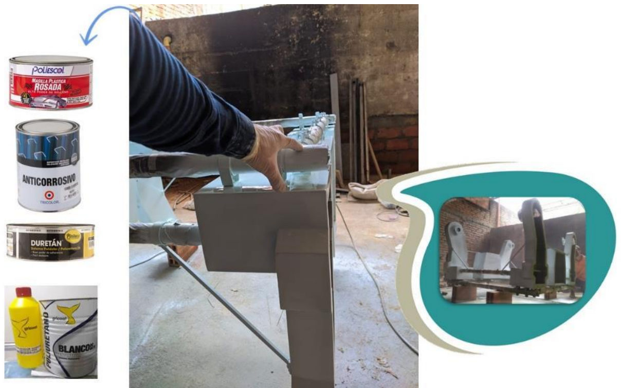
Figura 28. Última capa de pintura de poliuretano catalizada con sus respectivos productos.
