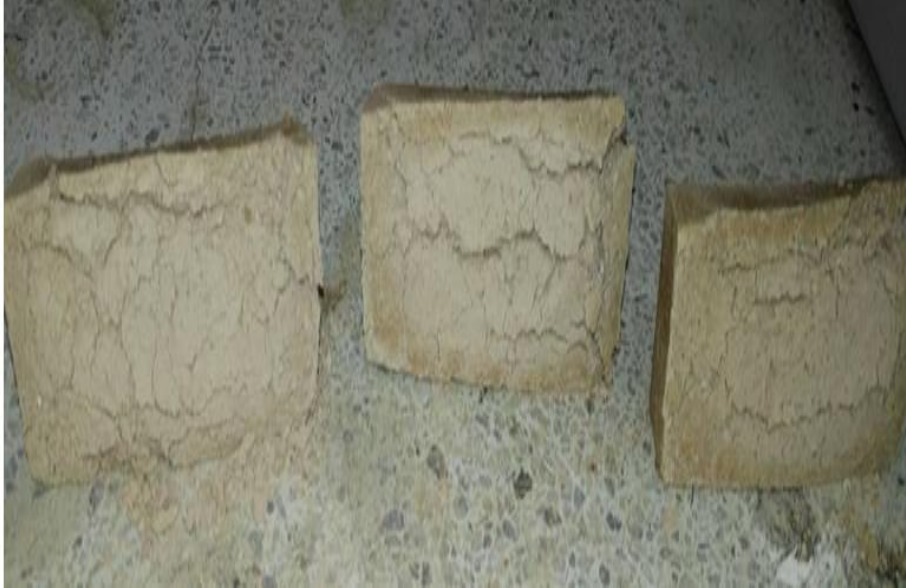
Figura 11. Evidencia de daños en la cara frontal del ladrillo
