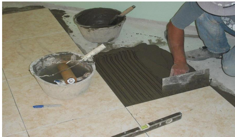
Figura D 1. Prueba de fraguado en piso porcelanato (dimensiones 60 cm X 60 cm) utilizando pegante cerámico gris.
