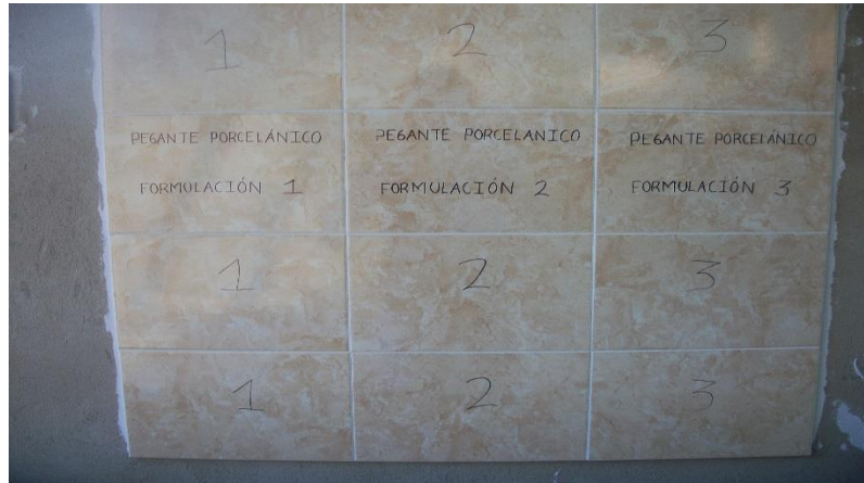
Figura D 6. Prueba de fraguado en pared sobre superficie cerámica-concreto (dimensiones 26 cm X 22 cm) utilizando pegante porcelánico.
