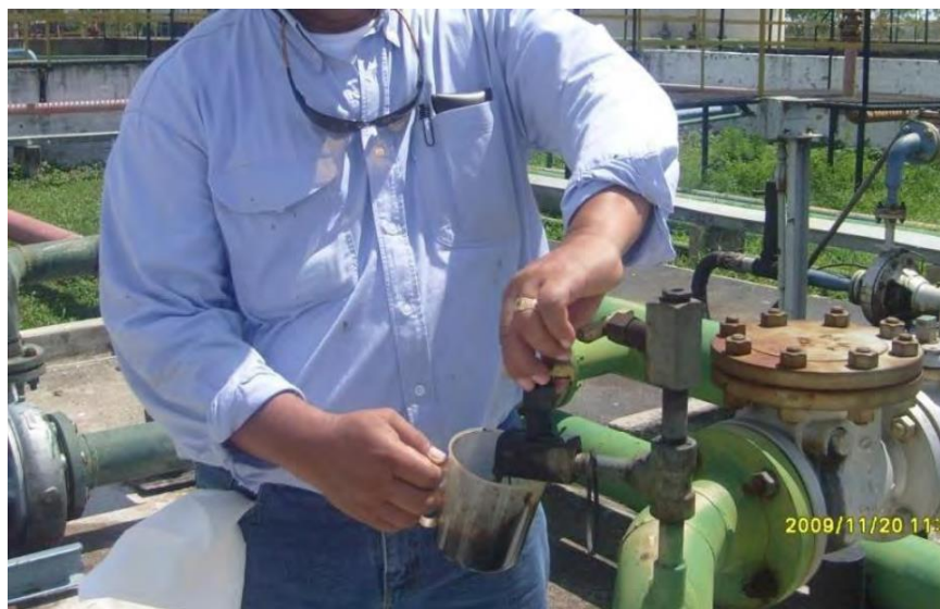
Figura 3. Borrás provenientes de una tubería.
