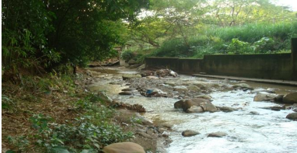
Figura 3. Tramo Quebrada Zapamanga
