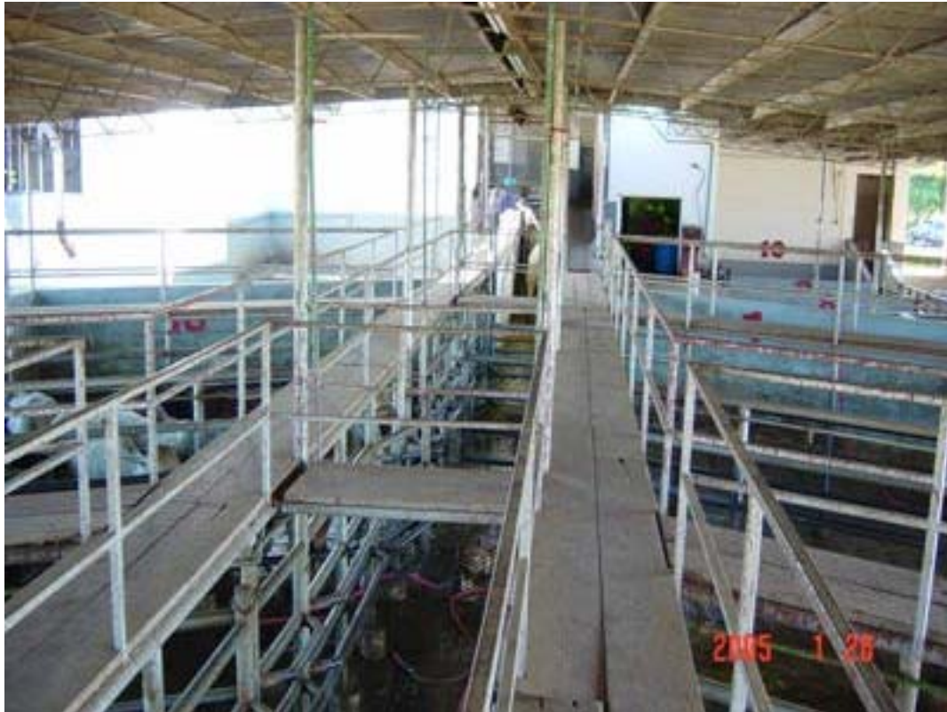
Figura. 4. Pasarelas para la inspección de reses
