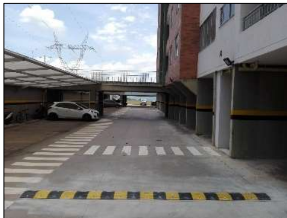
Figura 20. Resalto portátil instalado.
