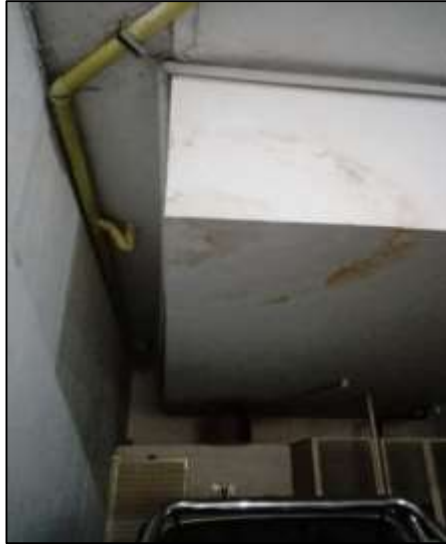
Figura 4. Visita realizada al conjunto residencial TRIVENTO junto a experto en impermeabilizaciones de la empresa SIKA COLOMBIA
