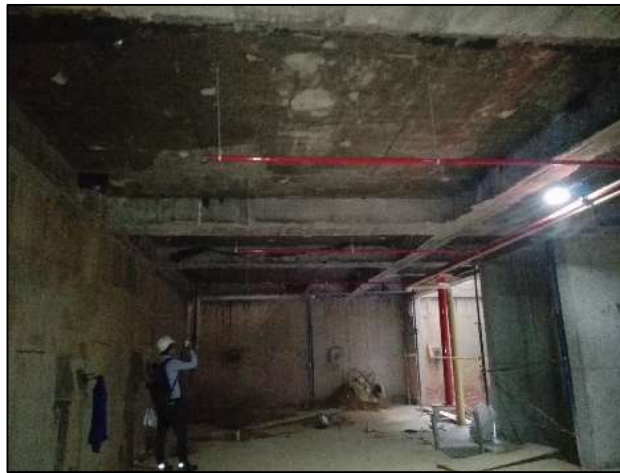
Figura 9. Visita a PHARMASAN para realizar control de obra.
