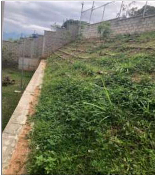
Figura 23. Talud ubicado en la parte trasera de torre 5 – conjunto residencial puerto viento.
