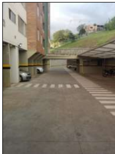
Figura 3. Visita realizada al conjunto residencial colina ruitoque junto a experto en movilidad de la empresa COMSEVIAS S.A.S
