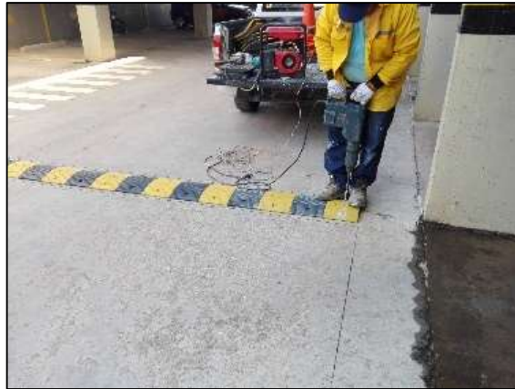
Figura 19. Proceso de instalación de resalto portátil.
