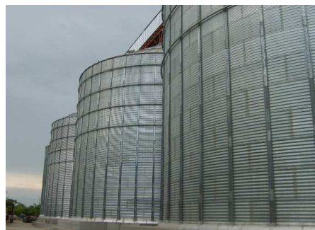
Figura 13. Silos de almacenamiento
