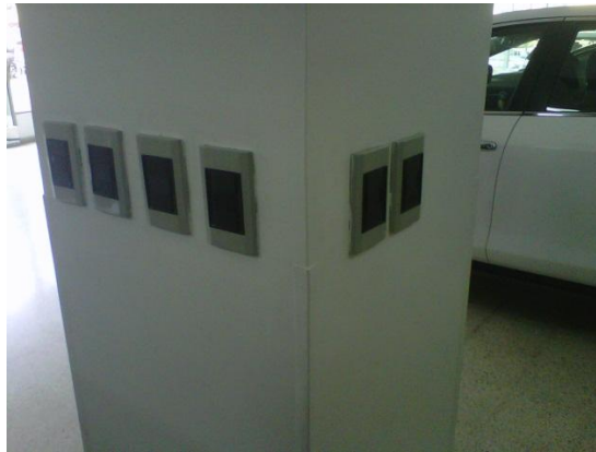
Foto 21. Adecuación de interruptores sala de ventas
