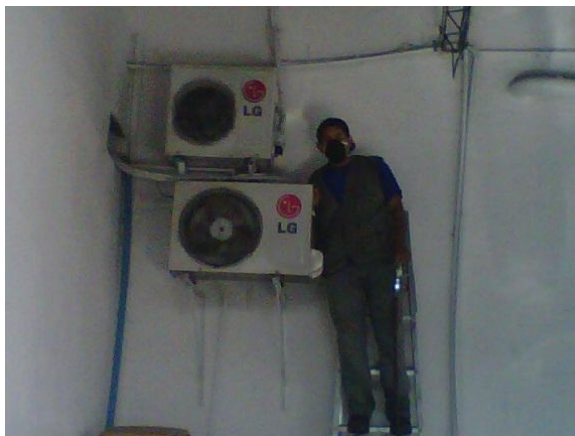
Foto 28. Mantenimiento aires acondicionados
