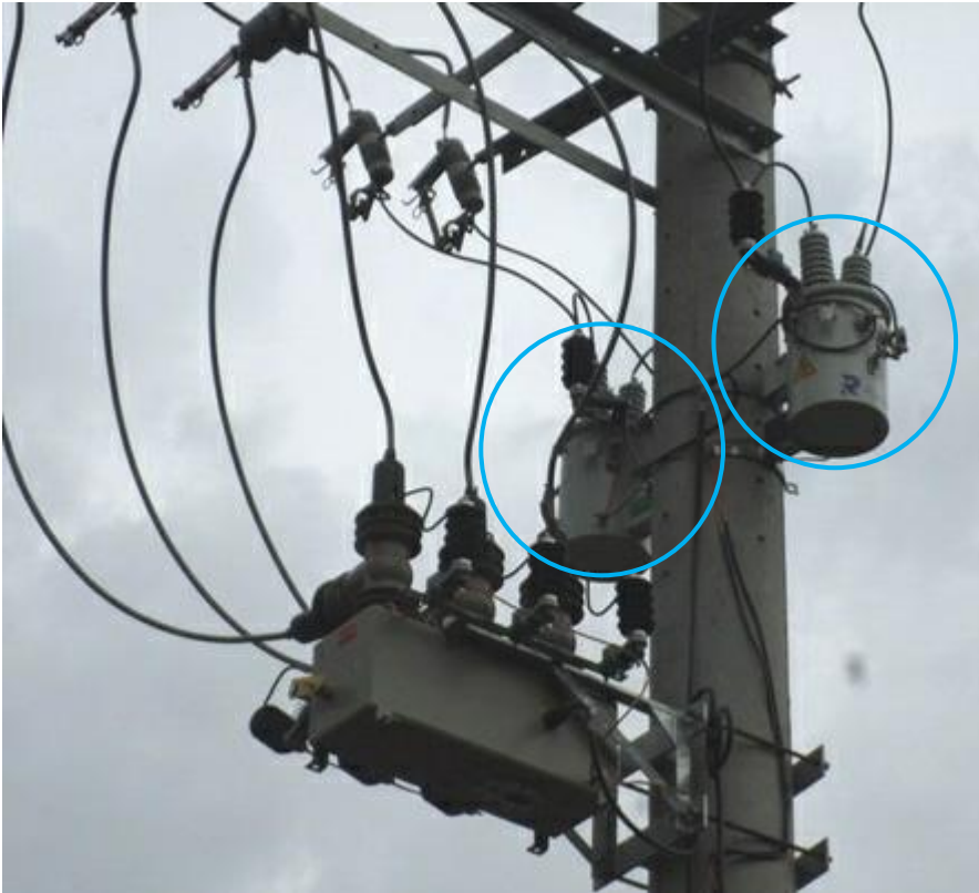
Figura 6. Reconector con doble alimentación AC
