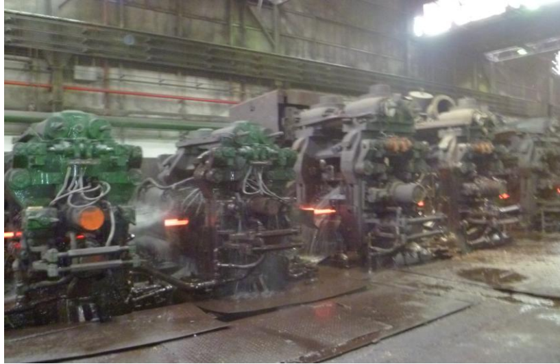
Figura 2. Refrigeración desbastador Tren Morgan
