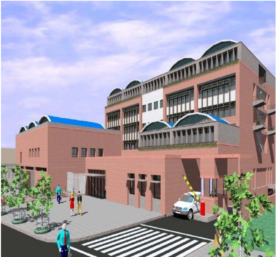
Figura 4. Acabados Arquitectónicos y Estructurales del Edificio de Ciencias Humanas
