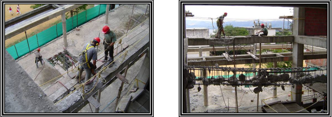
Figura 36. Demolición de Vigas para paso del Puente Peatonal.
