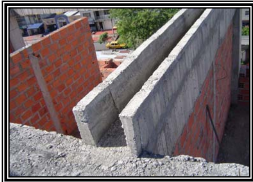
Figura 64. Recalce de Vigas Canal en cubierta.
