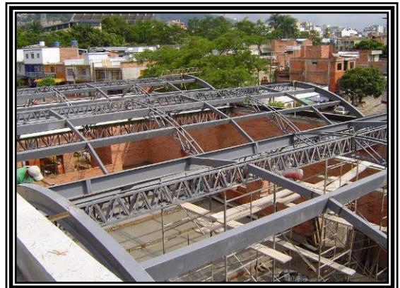
Figura 50. Uniones, soldadas y atornilladas de la Estructura Metálica.
