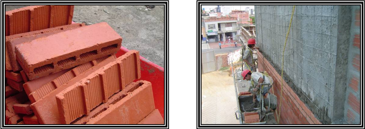
Figura 30. Detalle de Fachaleta o Enchape en mampostería a la vista.
