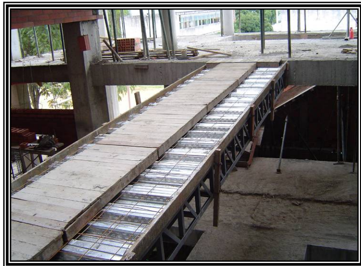
Figura 39. Estructura en Steeldeck del puente peatonal.
