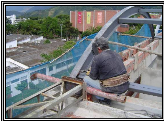
Figura 50. Uniones, soldadas y atornilladas de la Estructura Metálica.
