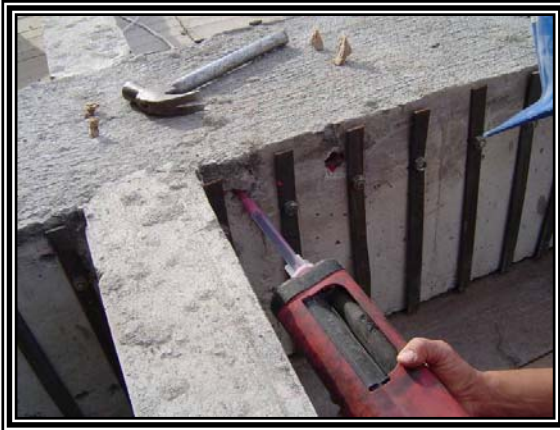
Figura 58. Otras aplicaciones para anclajes.
