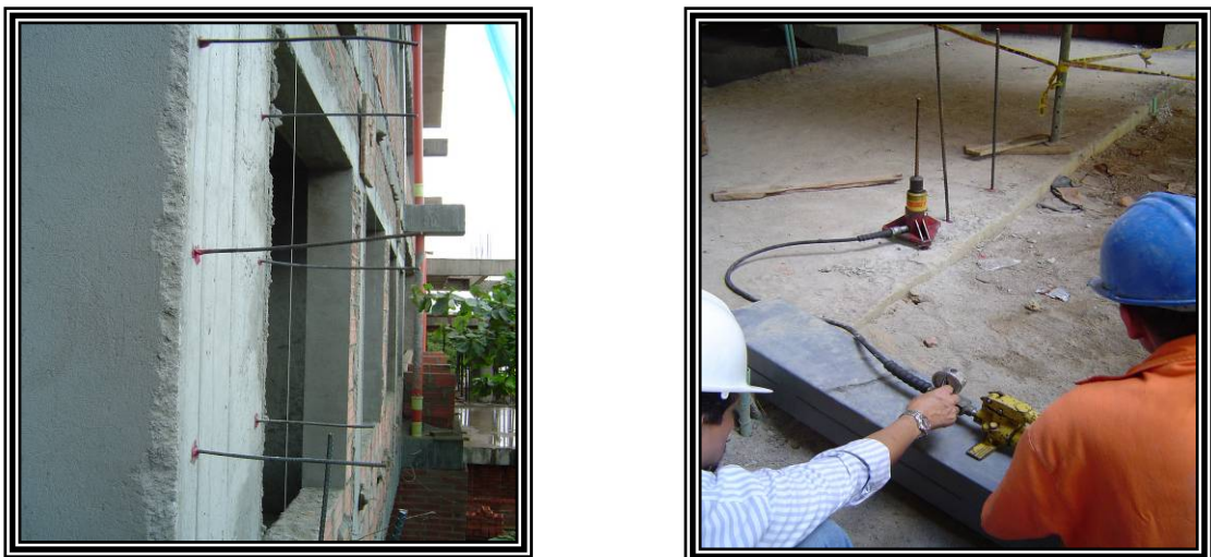
Figura 18. Realización de Pruebas para anclajes de \frac{1}{2} ".
