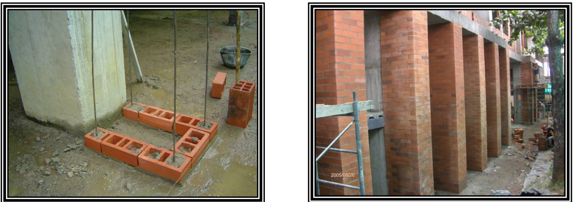
Figura 29. Detalle de Torreones en ladrillo a la vista.
