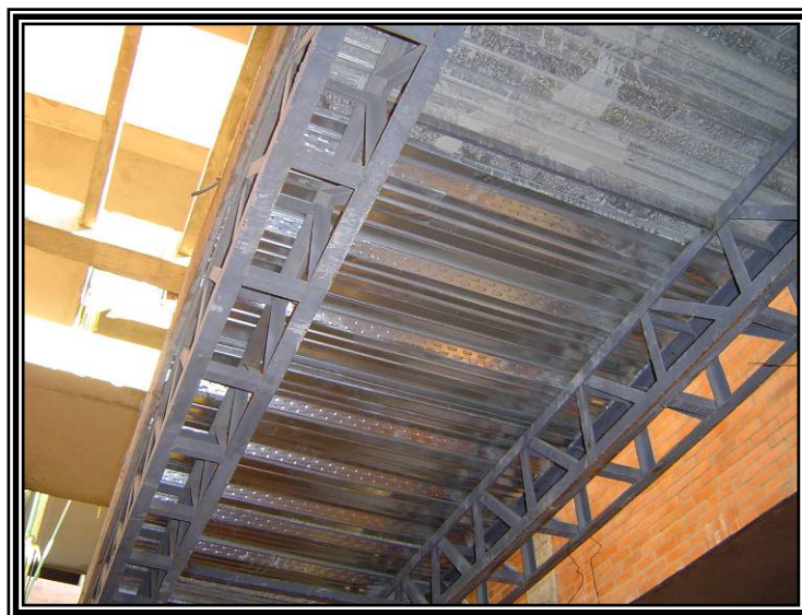
Figura 48. Instalación de viga metálica del puente peatonal.
