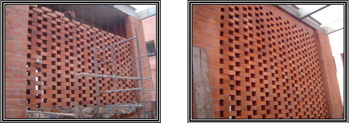
Figura 28. Detalle de Muros en calado en ladrillo a la vista.
