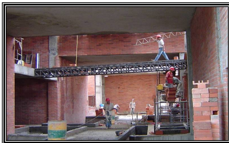
Figura 37. Vista de Perfil del Puente peatonal que comunica el Edificio de Ciencias con la Antigua Nacional de Comercio.
