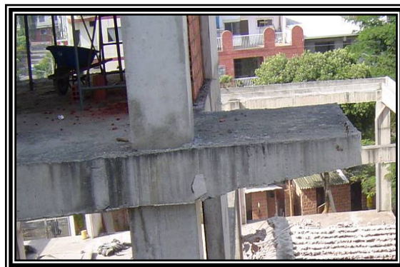
Figura 32. Placas de estructura a demoler.
