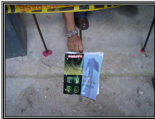
Figura 55. Prueba de anclajes con productos de HILTI
