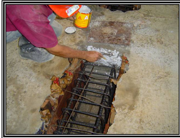
Figura 54. Aplicación del Sikadur 32 primer para concreto nuevo.
