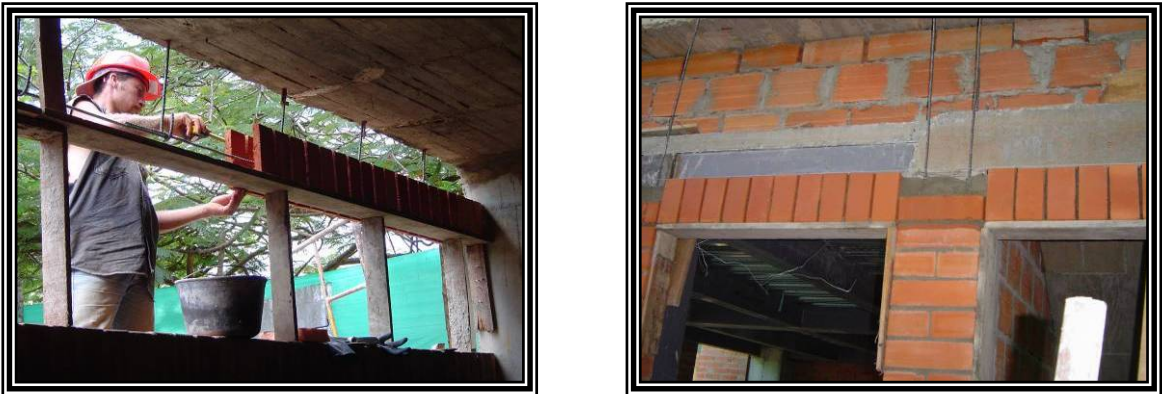
Figura 31. Detalle de Dinteles en mampostería a la vista.
