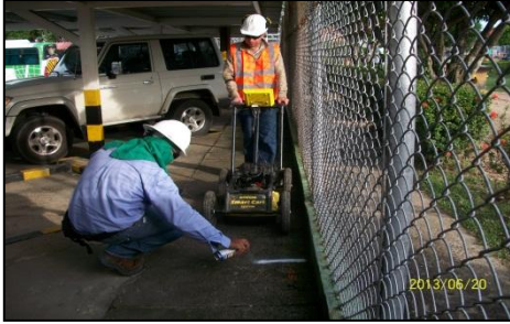
Figura 19. Detección con Ground Penetrating Radar. [13].
