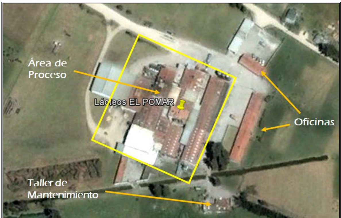
Figura 1. Vista satelital de la planta.
