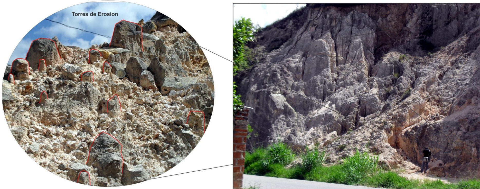
Figura 16, Afloramiento del Granito de Pescadero, donde podemos apreciar la erosión en Cárcavas y proceso de Carcavamamiento (Parte Derecha), y Torres de Erosión (Parte Izquierda)
