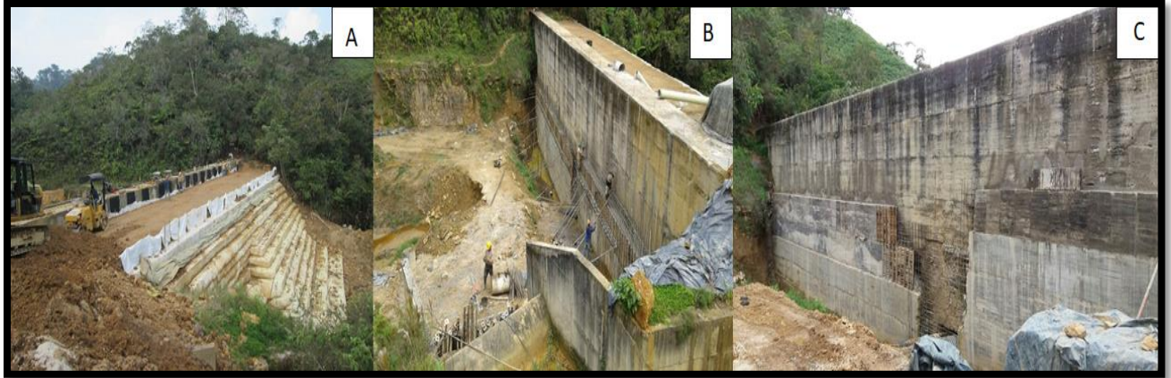
Figura 10. Estado de la presa año 2015-2016; (A) muestra la construcción del nuevo terraplén de soporte; (B) y (C) construcción de pantalla de refuerzo delante del muro de presa. Fuente: Imágenes tomadas y modificadas de la recopilación fotográfica Contrato No. 1916-15.
