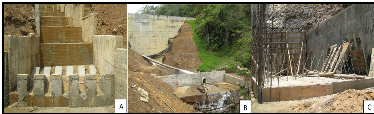
Figura 6. Estado de la presa año 2008. (A), (B) y (C), construcción del nuevo canal de excesos.
