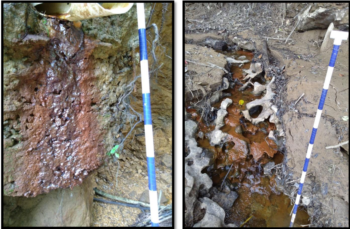
Figura 45. Evidencias de oxidación del agua y karstificación en el sito de presa.
