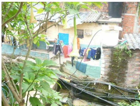
Las viviendas están al borde de una Quebrada que emite malos olores.
