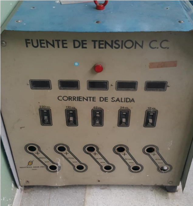
Figura 4. Estado inicial de las conexiones de salida
