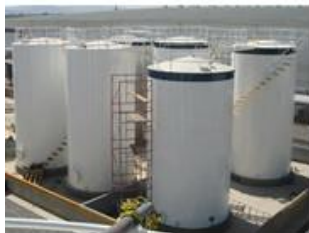
A) Tanque de almacenamiento vertical.
