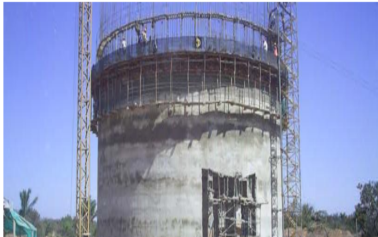
Figura 6. Silo La loma, Cesar.
