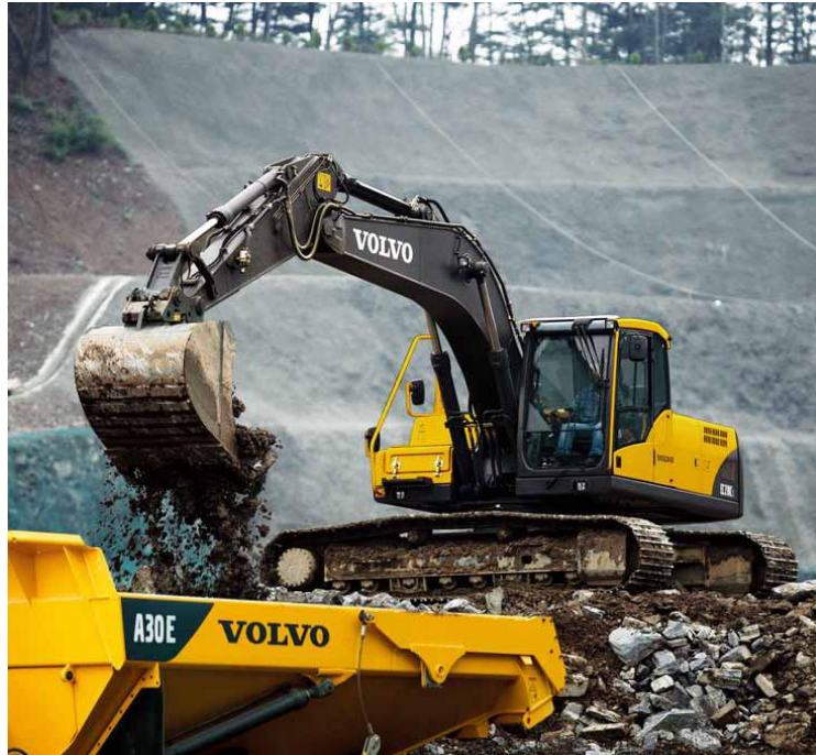
Figura 10. Retro excavadora Volvo EC 210B
