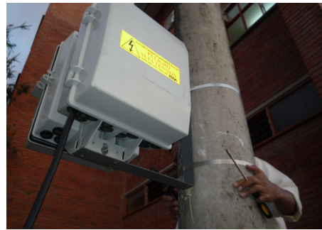
(e) Cajas armadas listas para instalar en el poste.
